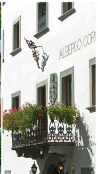
La facciata con poggolo ottocentesco. A sinistra: l'ingresso con il portale in cornice ad arco di prassinitie verde locale.
