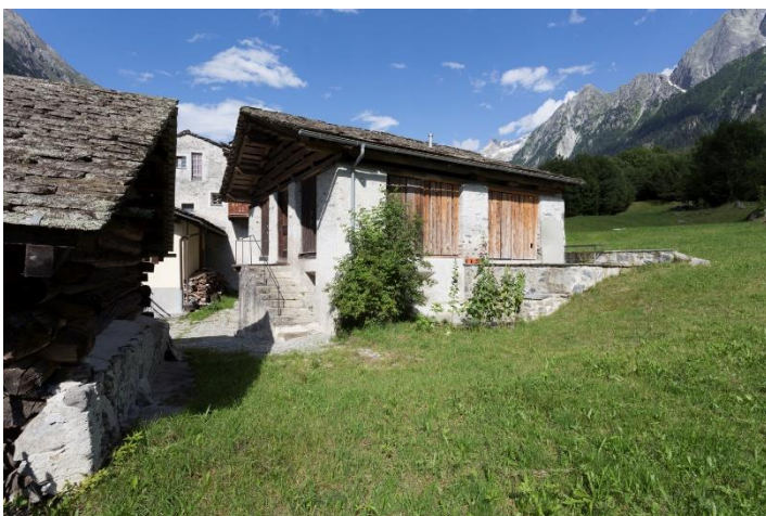
Foto 2: Trasformazione di una stalla, Stampa, arch. André Born, 2012 (© James Batten/Heimatschutz Svizzera)
